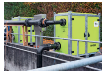
Zwei selbstsaugende ELMA Pumpstationen im Einsatz während der Revision des Hebewerks.
